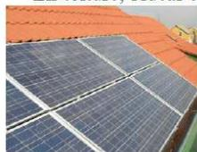
Il est rare que les proportions des panneaux s'accordent avec celles du toit. Ne pas laisser une frange de quelques tuiles autour des panneaux. La différence de couleur ne fera que ressortir l'installation. Si la pente du toit ne permet pas une inclinaison suffisante des capteurs, n'installez surtout pas un châssis sur le toit ou une "rehausse" sur "béquilles". D'autres solutions, au rendu plus esthétiques, sont envisageables. Cette solution n'est possible que sur les toitures terrasses.
