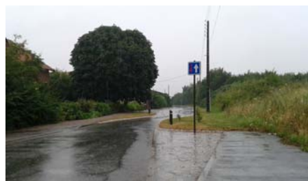
La chicane écluse de Remiencourt
