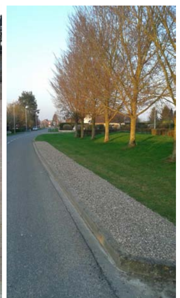
La réalisation d'un trottoir rue de Saint Sauffieu pour les usagers des bus de Trans'80
