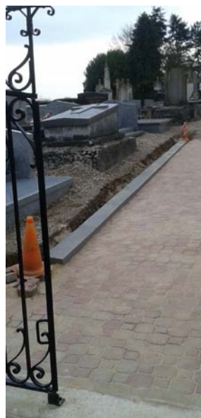
La création d'une allée accessible aux personnes à mobilité réduite.
