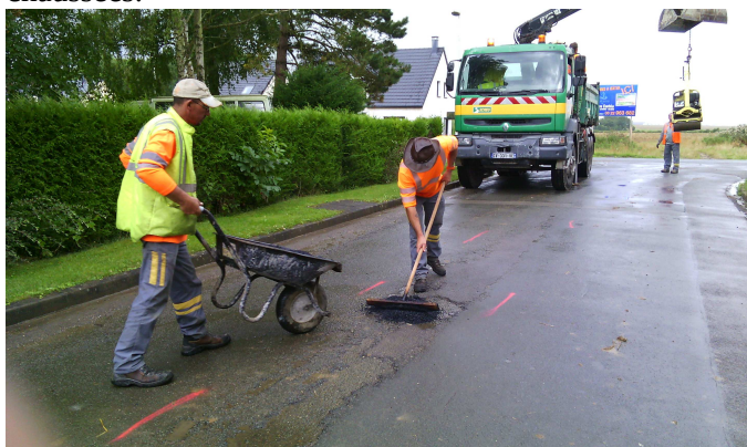
Entretien de la chaussée rue de Vers
